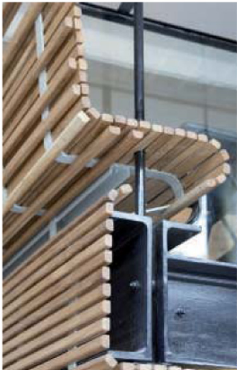
▲ La tonnelle façonne un garde-corps et une nouvelle assise.
