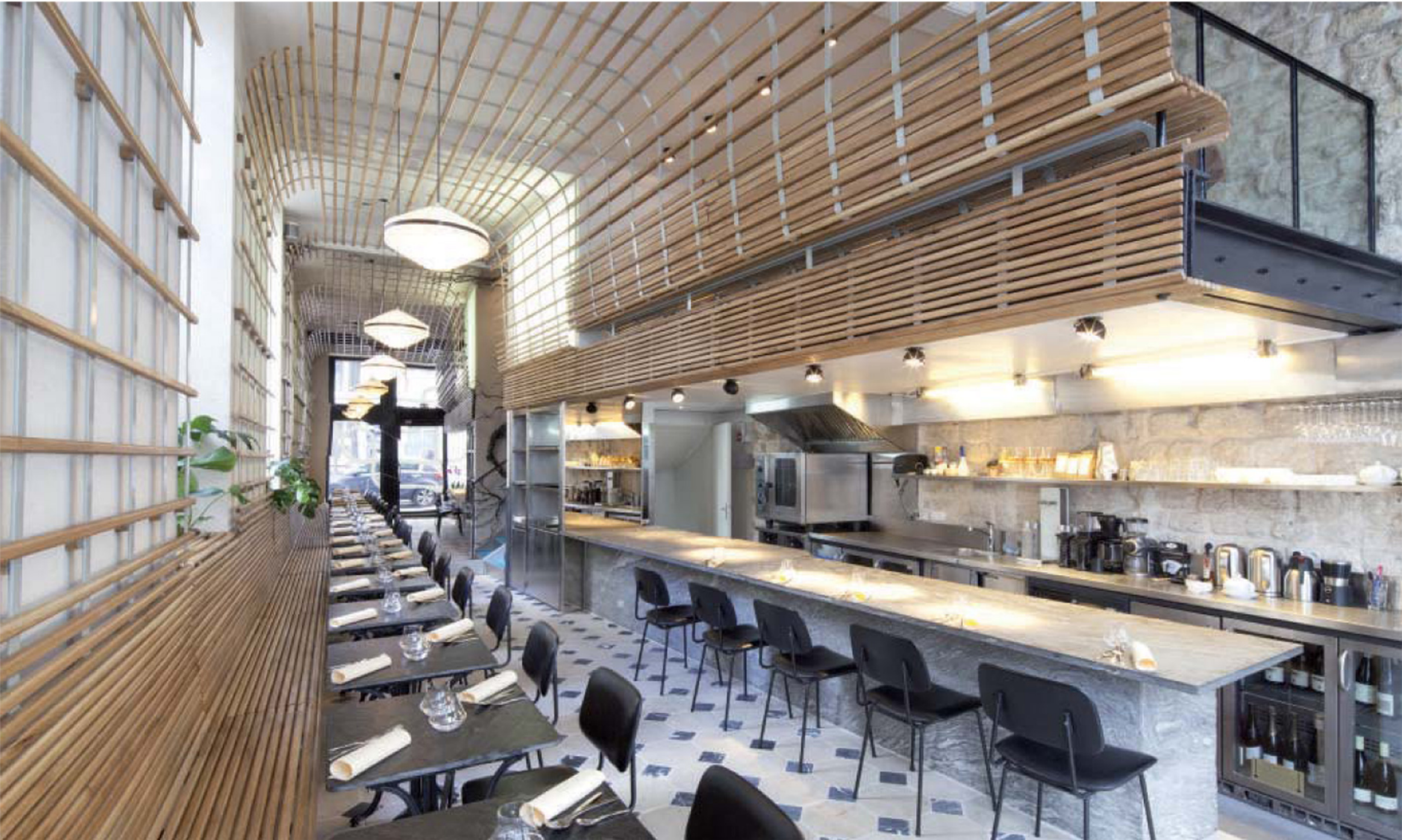
▲ Évoquant les armatures des jardins d'hiver, des tasseaux de chêne habillent le beau volume de l'assise au plafond.
